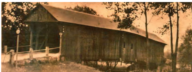
Die alte Kunitzer Hausbrücke kurz vor ihrer Sprengung 1945
